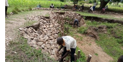
Fascines pour freiner l'érosion des berges de cours d'eau
