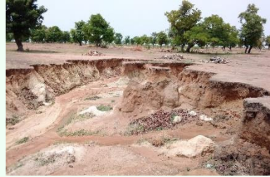
Erosion des berges des cours d'eau
