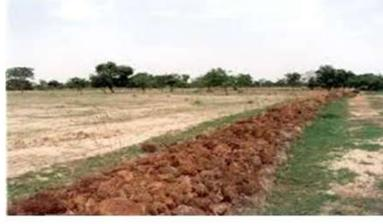
Il s'agit d'ouvrages mécaniques constitués de pierres libres ou de gabions construits à l'opposé d'une ravine.
